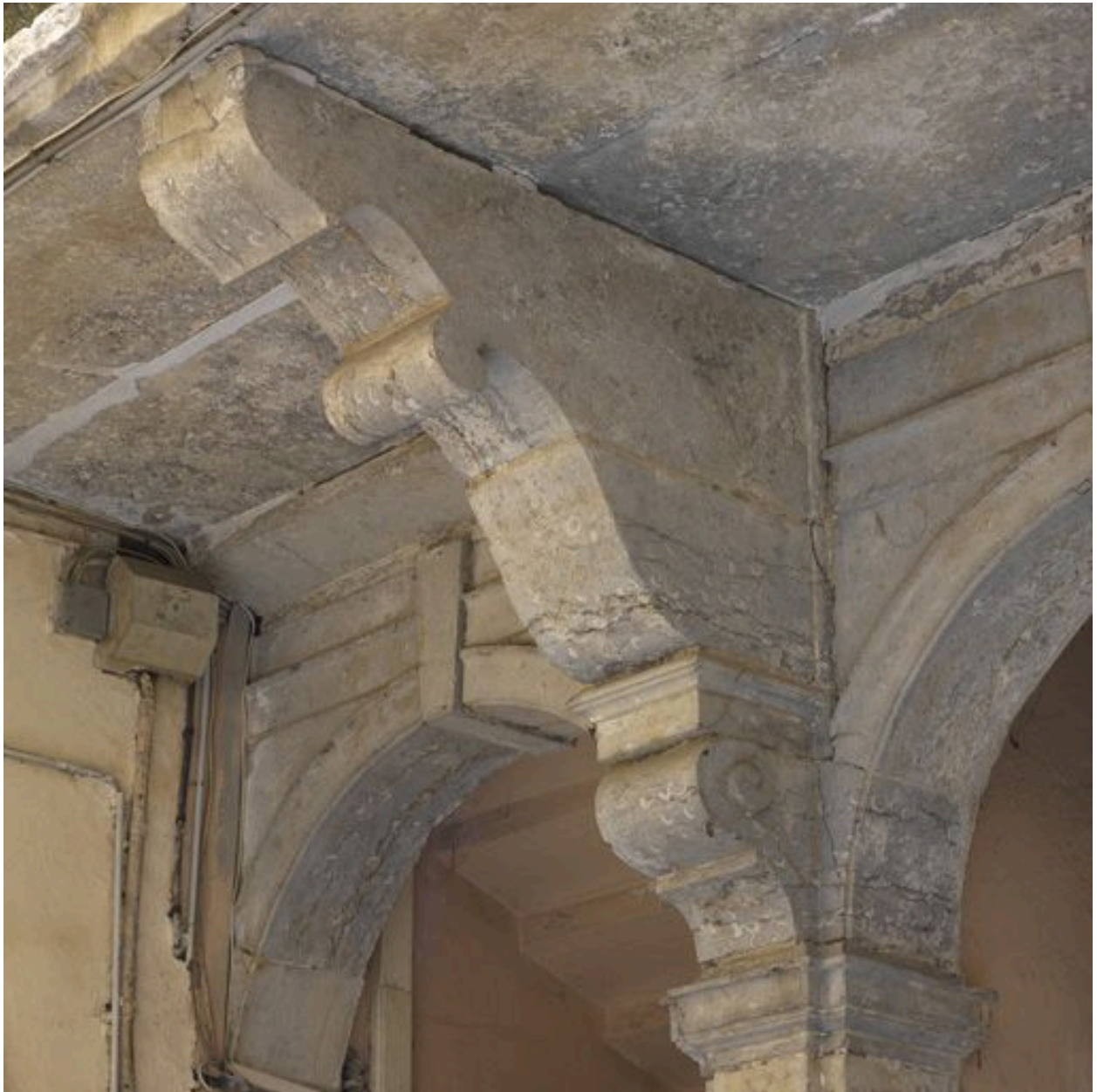
Cour, escalier, détail d'une console soutenant le palier du 2e étage
