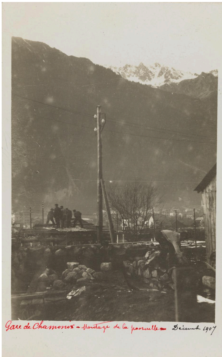
Gare de Chamonix, montage de la passerelle. 1907 (AD Haute-Savoie : 36 Fi 536)
