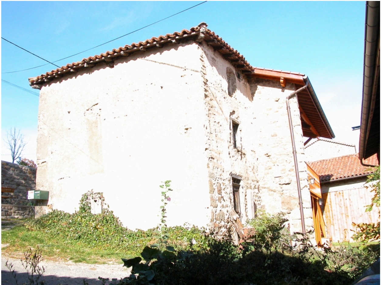
Logis de ferme à Chazelles (non repéré, 1986 E2 472).
