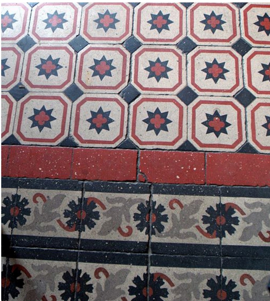
Vestibule, carrelage en carreaux de ciment
