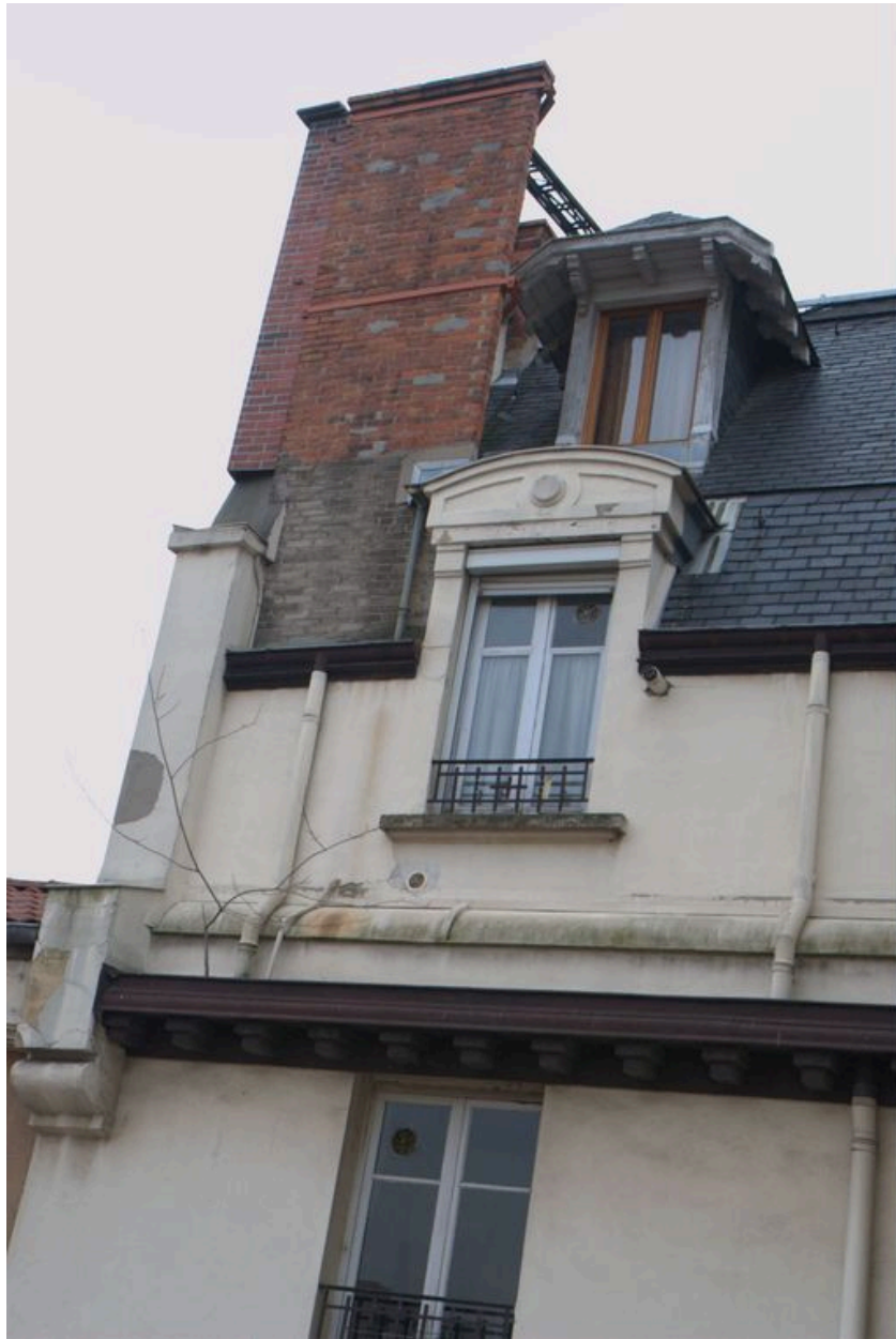
Baies des combles, côté cour
