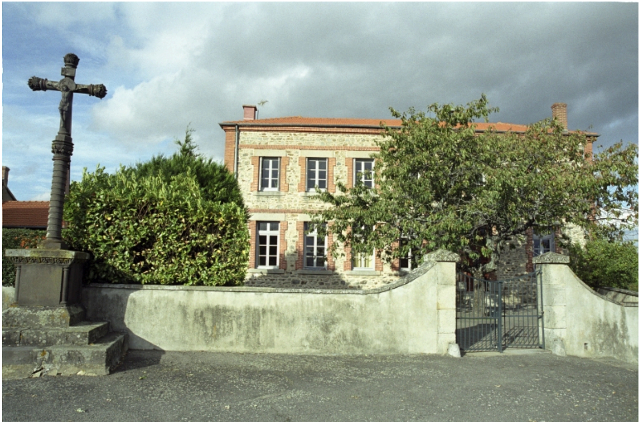
Vue d'ensemble de la nouvelle école.
