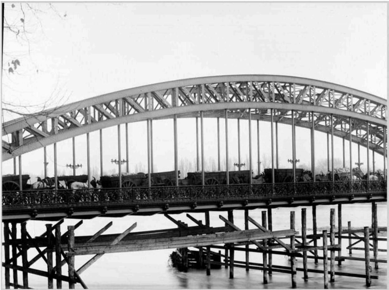
La construction du pont de la Boucle. L'épreuve de charge. [1903]. 1 fotogr. : n. et b. (AM Lyon. 15 Ph 1837)
