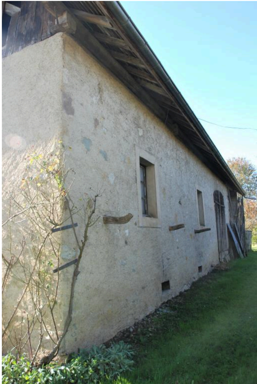
Vue d'ensemble de la façade arrière de la ferme.
