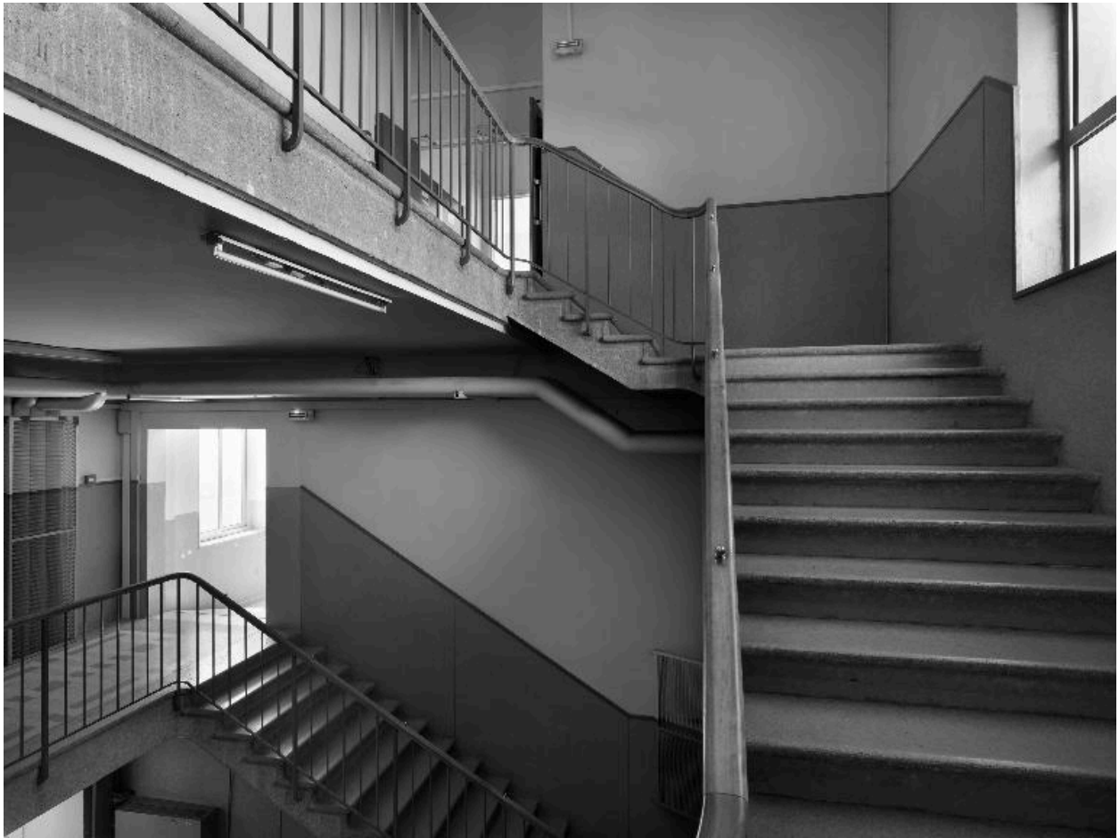
Bâtiment principal : escalier, 2e révolution
