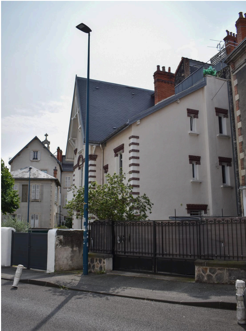
Elévation ouest sur la rue de Thiers
