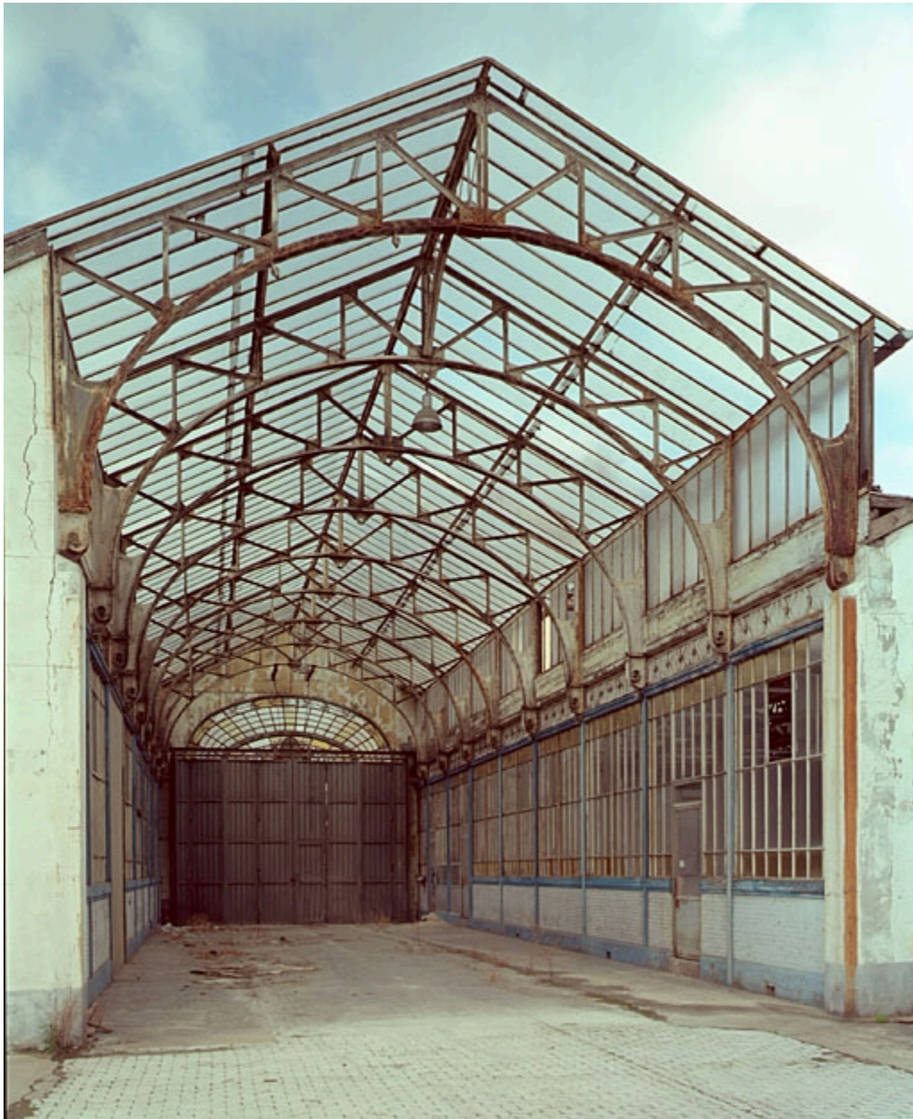
Vue d'ensemble de la verrière
