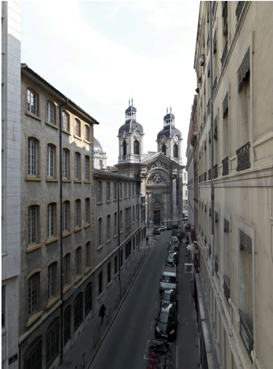
Bâtiment S. Façades ouest, rue Marcel-Gabriel-Rivière
