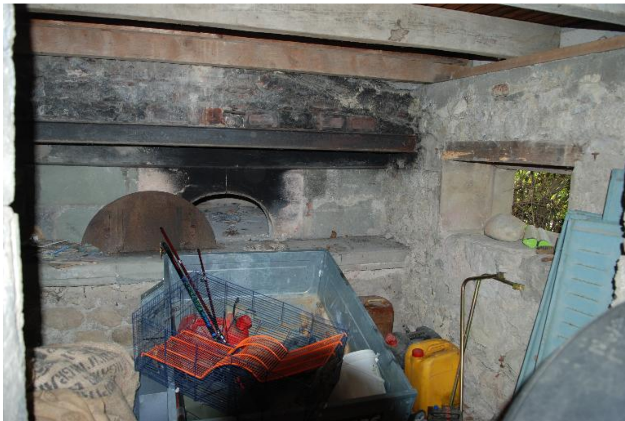
Vue générale intérieure du four.
