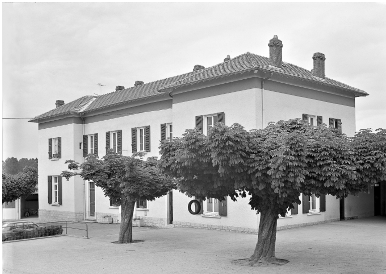
Vue du sud-ouest.
