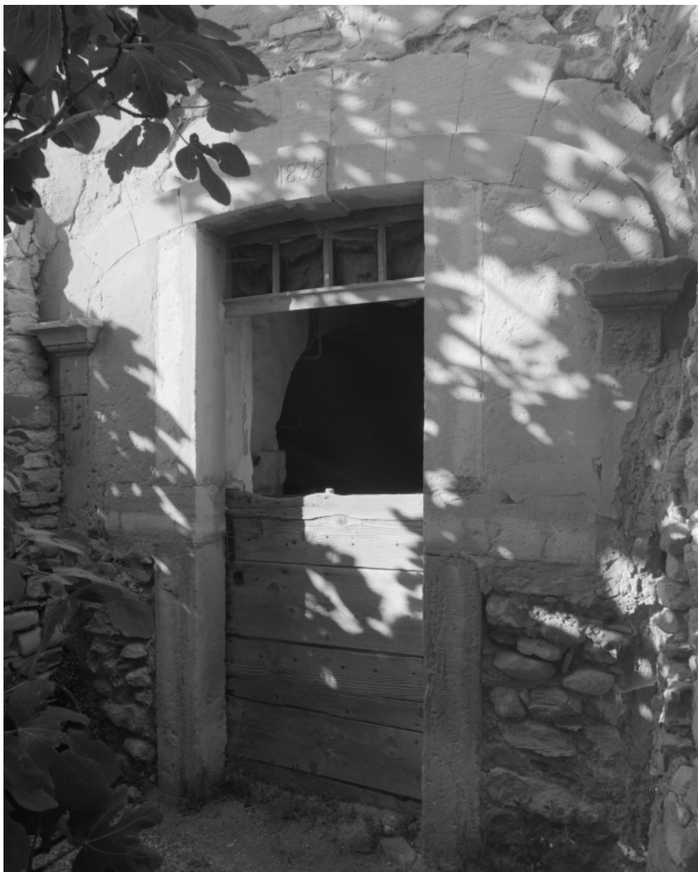
Détail d'une porte de dépendance remaniée portant la date 1838.
