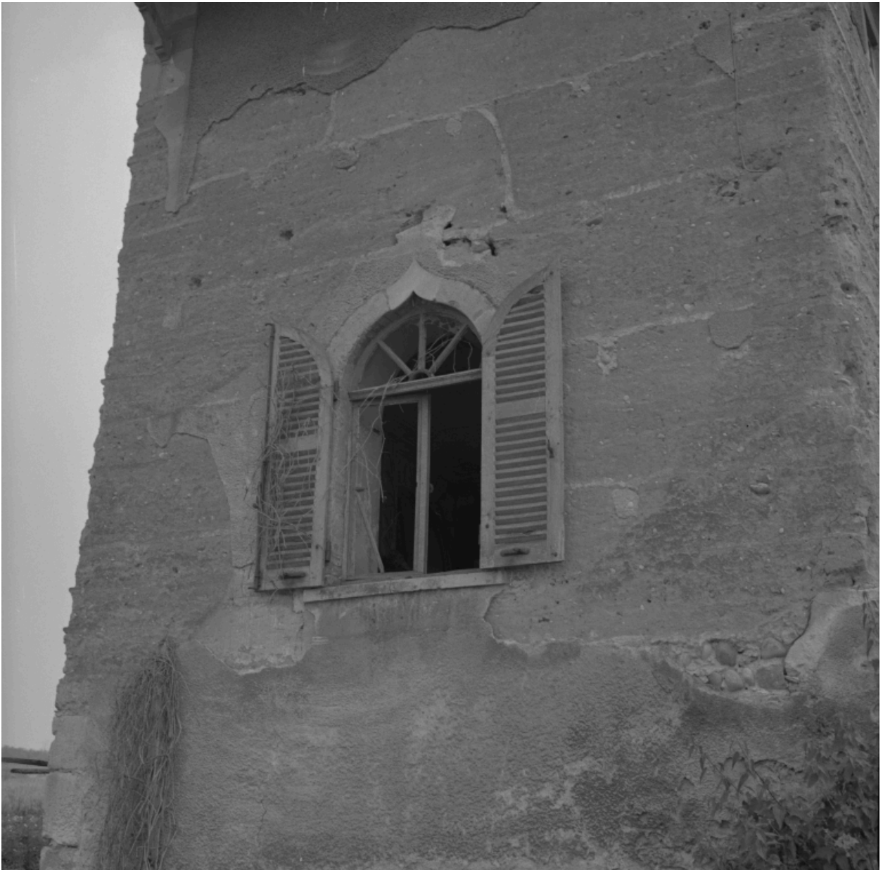
Elévation nord, détail : fenêtre au rez-de-chaussée surélevé.
