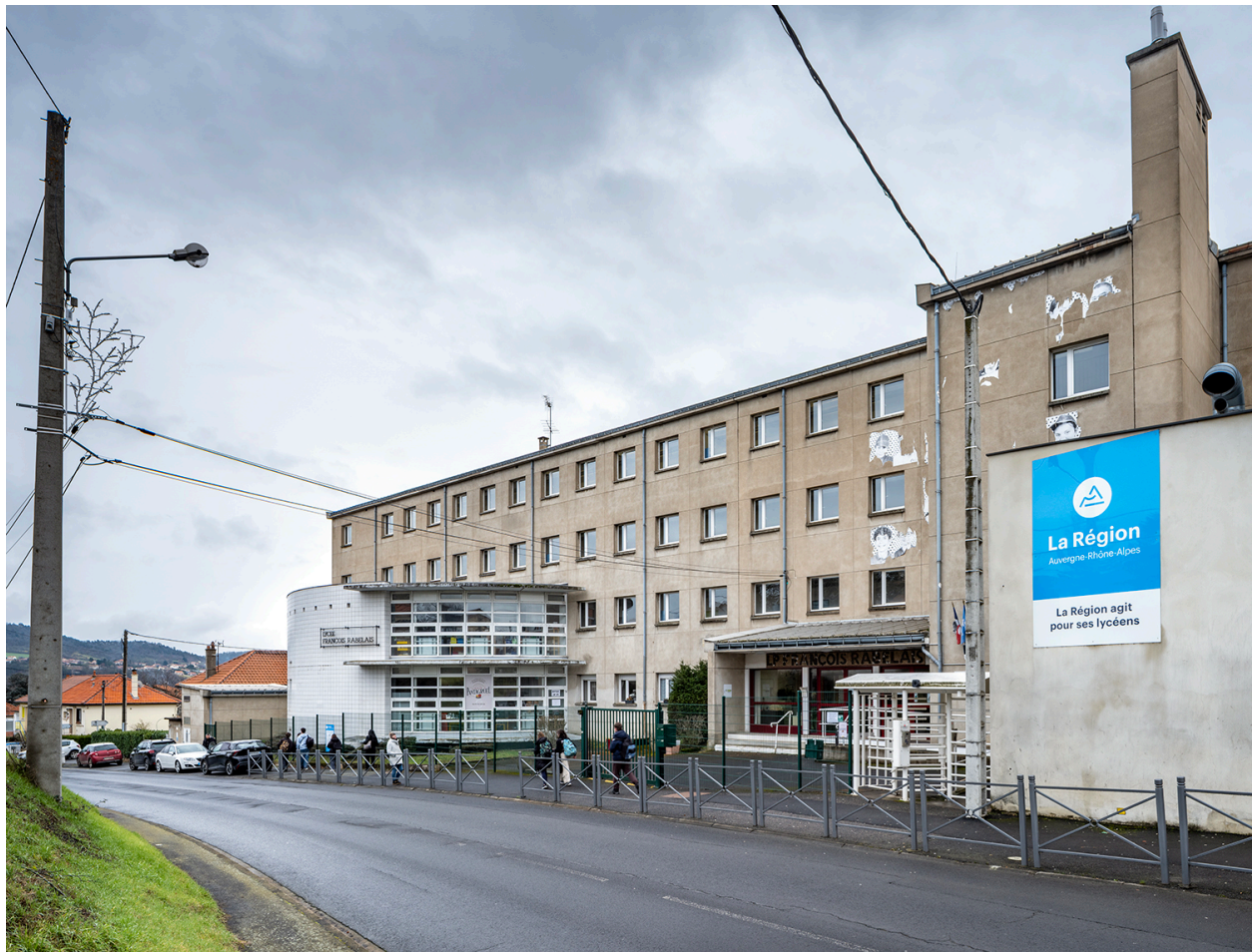
Élévation principale depuis le nord-ouest
