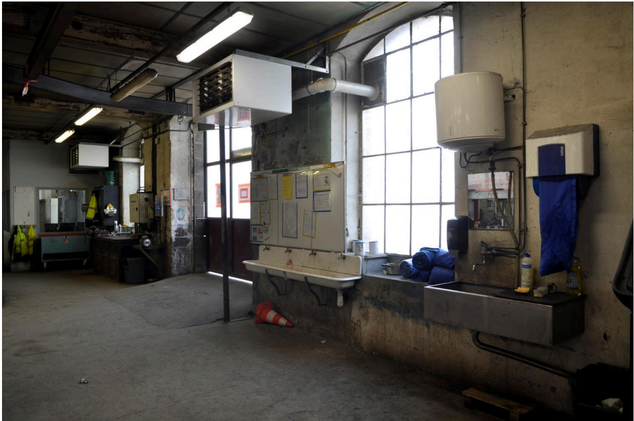
Vue de l'intérieur des ateliers
