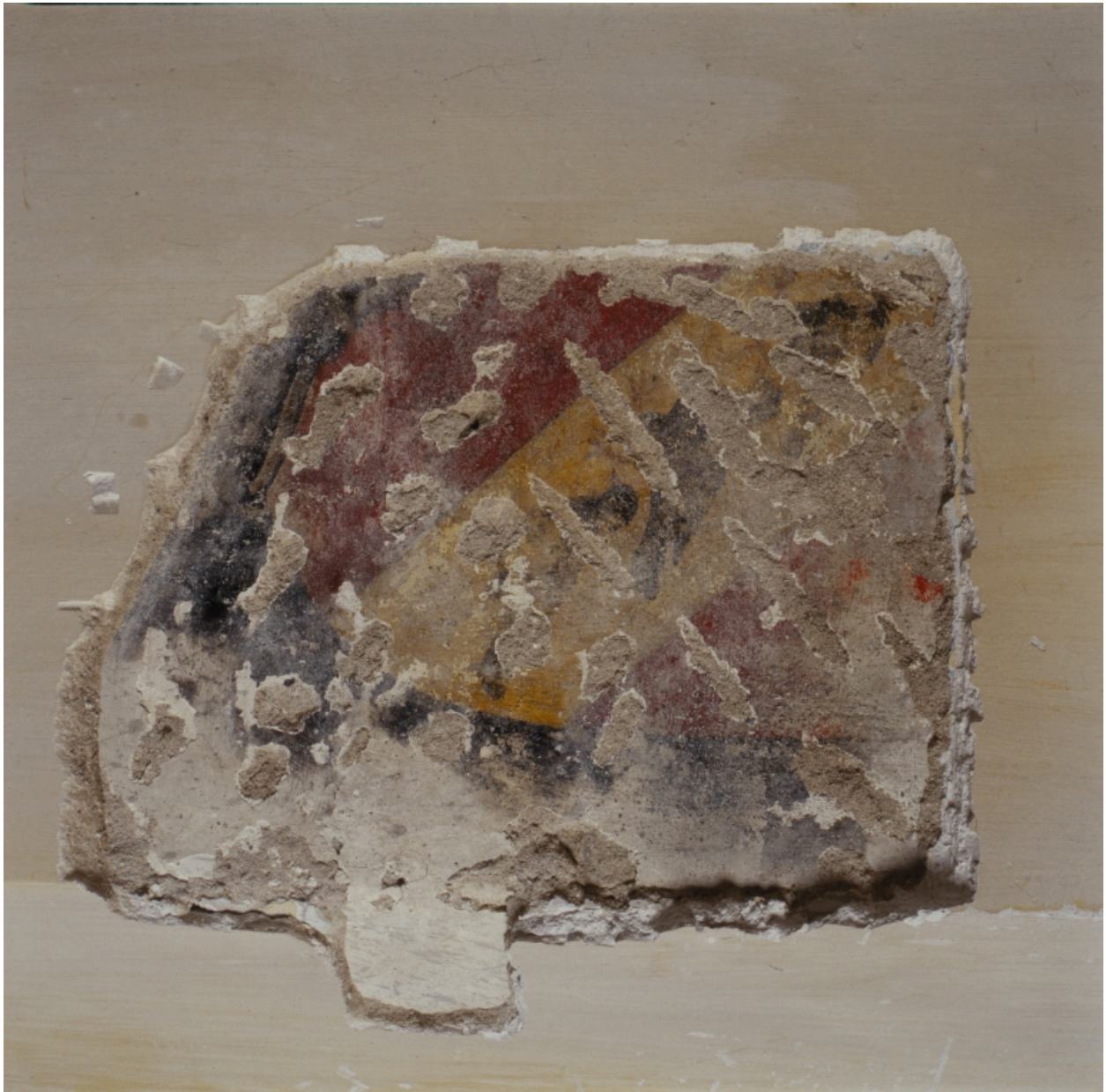
Détail du blason de la Merlée en cours de dégagement dans l'embrasure de la fenêtre nord de l'abside (juin 2002).
