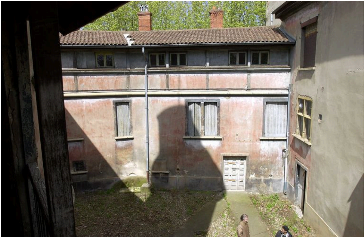
La cour : façade de l'aile nord, état en 2001
