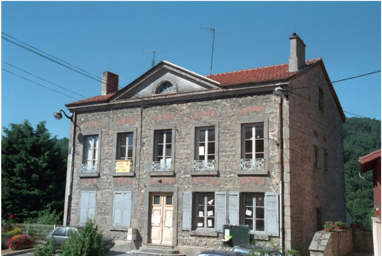
Boën, îlot 13, André Boni (place). Vue générale de la façade sur rue.
