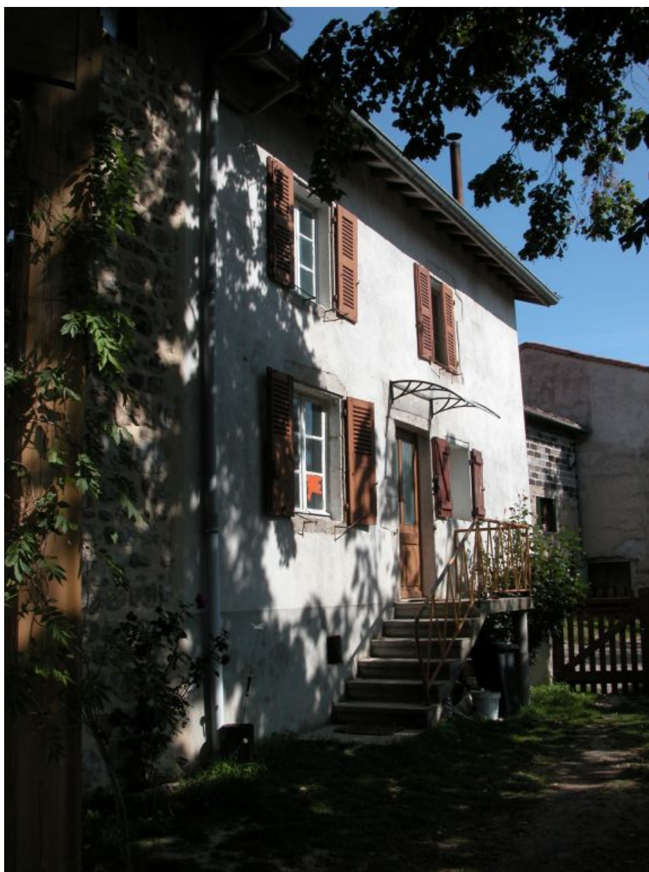
Vue d'ensemble du logis de la ferme.
