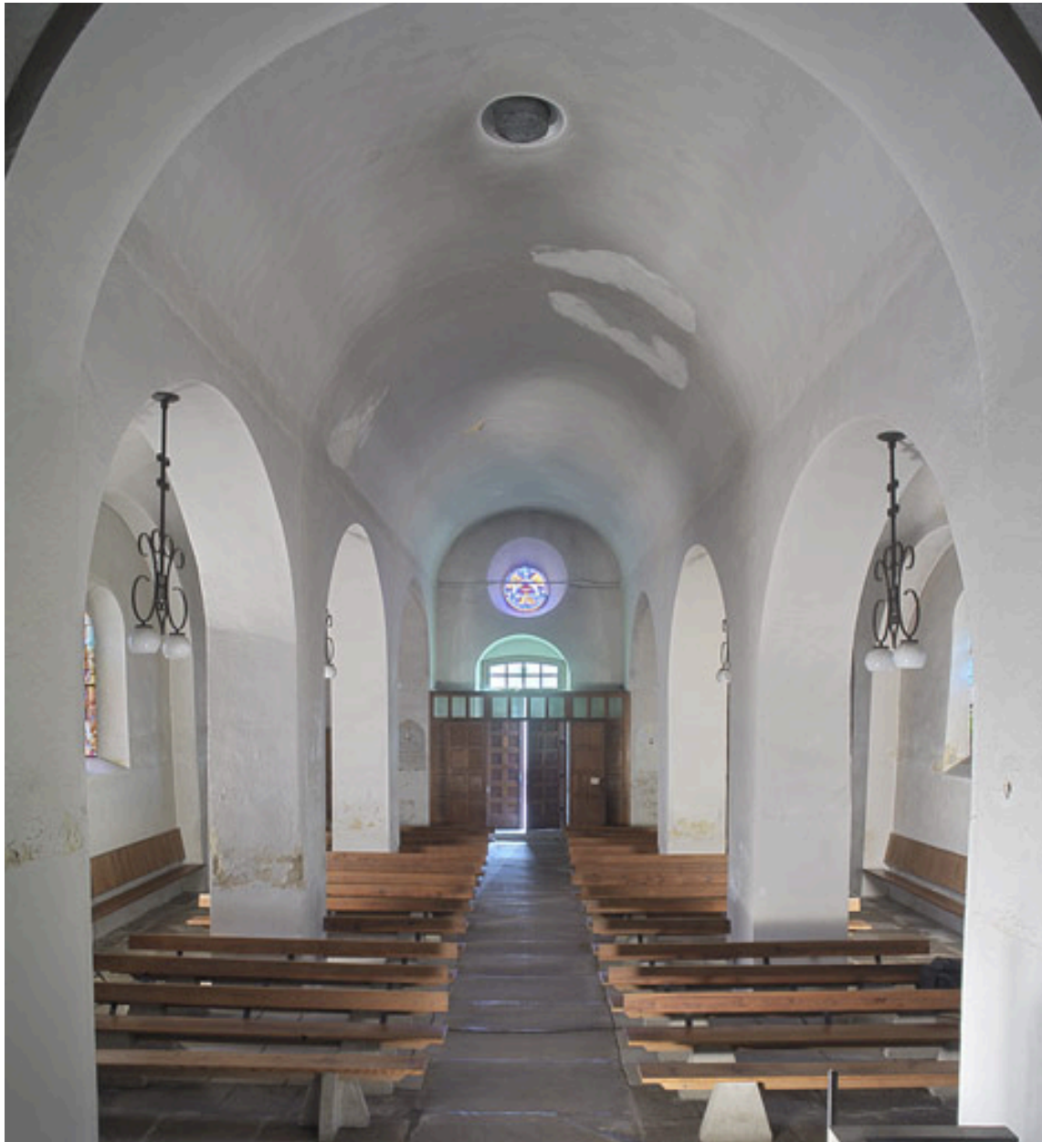
Vue d'ensemble intérieure en direction de l'entrée.
