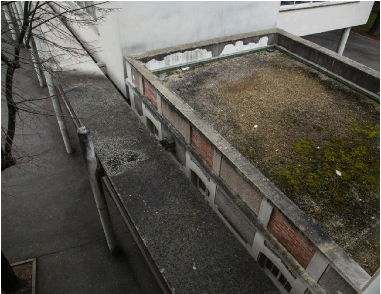
Bâtiment sud : terrasse du pavillon en retour et de la galerie
