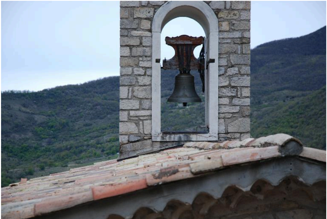
Vue d'ensemble (en place).
