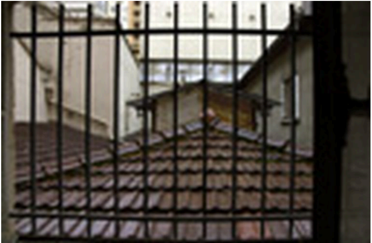
Vue du lanterneau du garage depuis le 3 rue de Savoie
