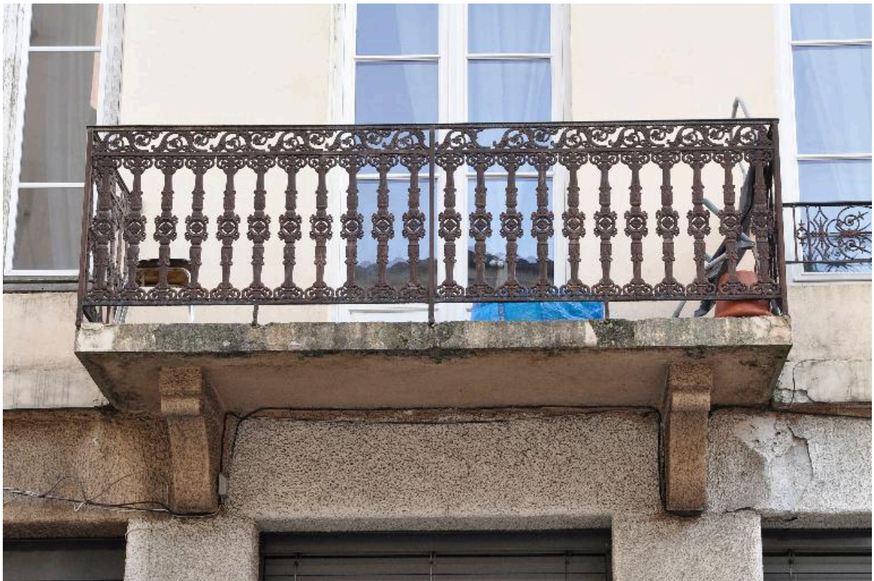
Rue Montesquieu, balcon, garde-corps en fonte
