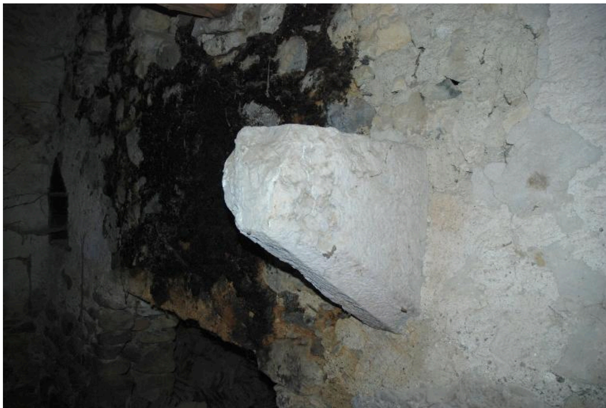
Détail de la console supportant le linteau (disparu) de la cheminée.
