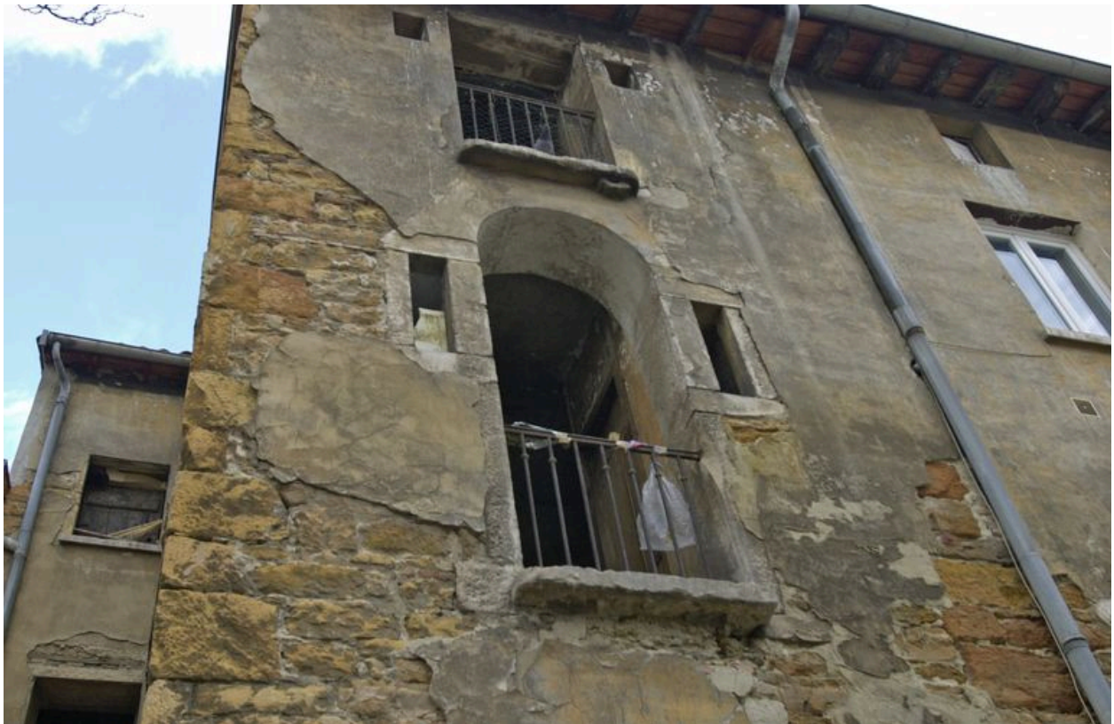
Partie supérieure de la travée d'escalier vue depuis la cour
