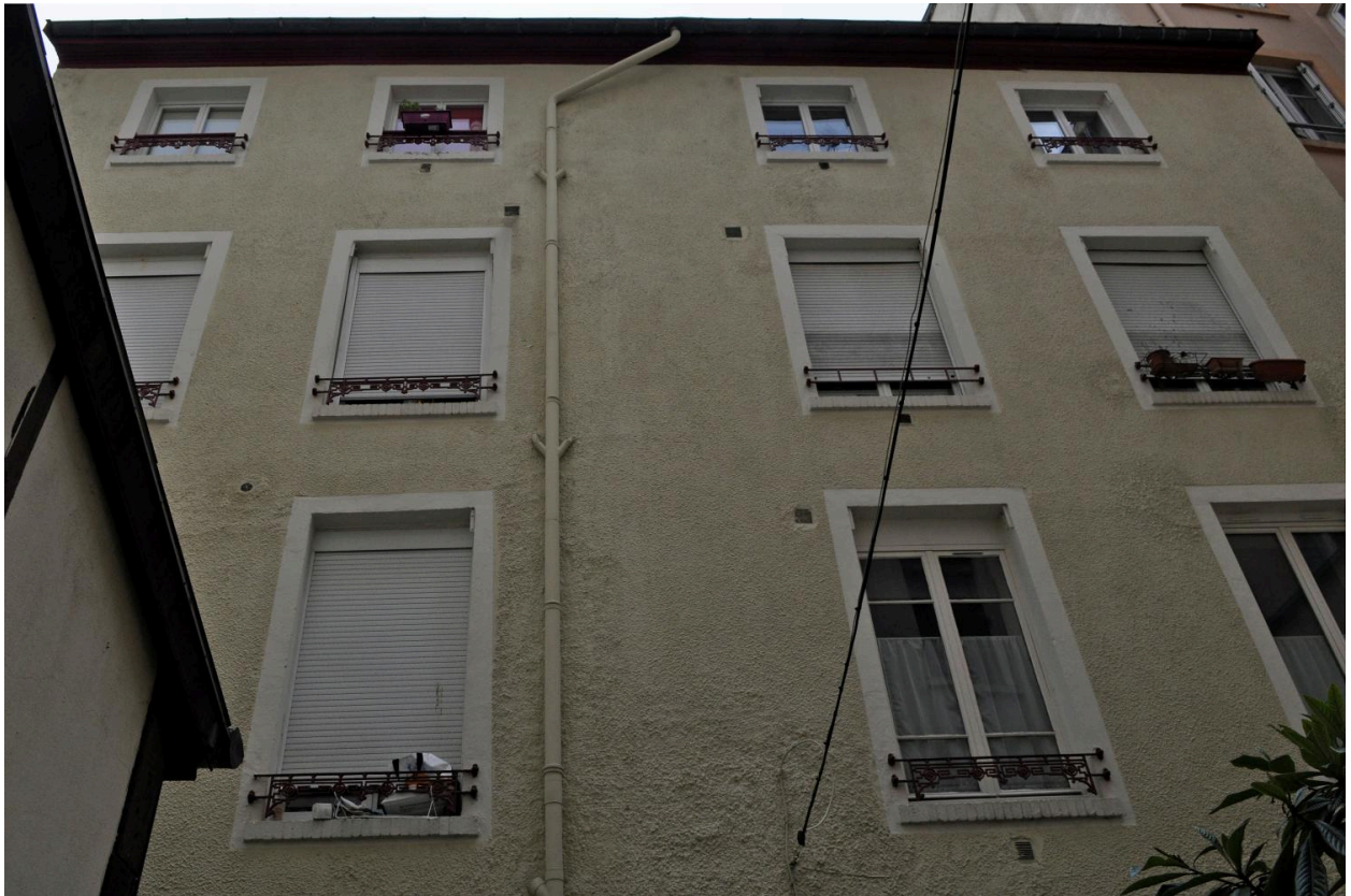
Immeuble sur rue, vue partielle de la façade postérieure
