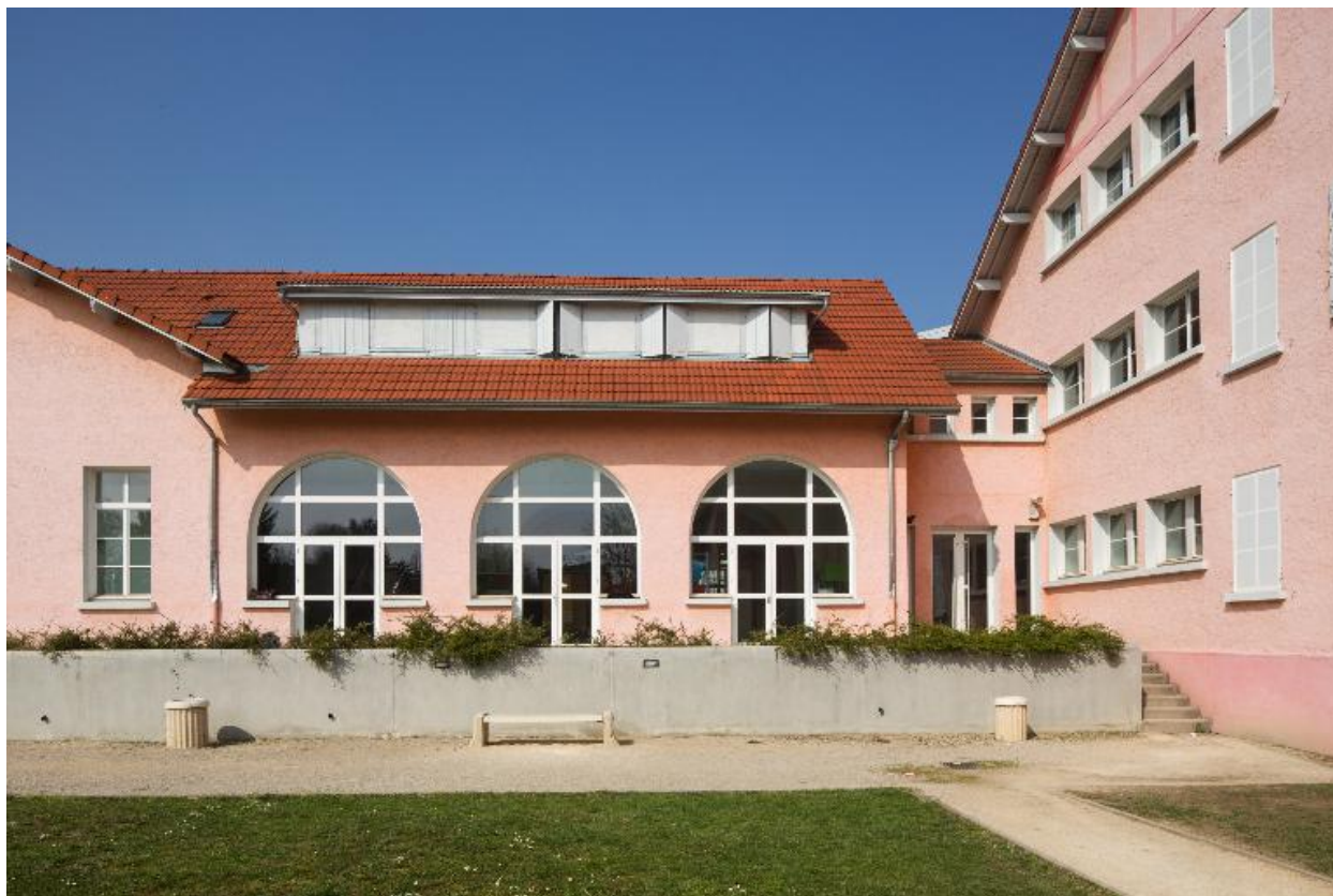
Bât. A : couloir de distribution du corps principal, partie est
