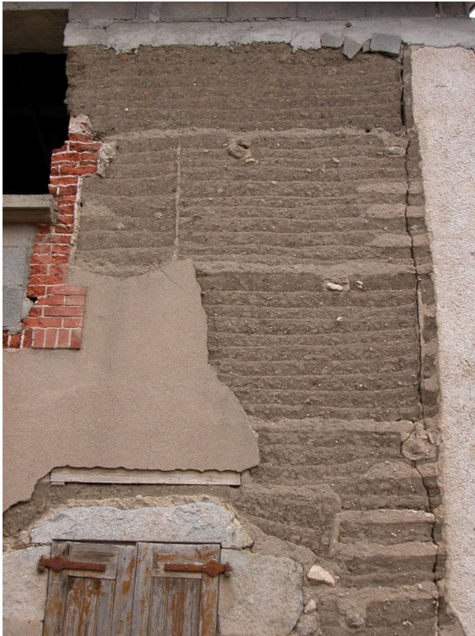
Faubourg du Rosaire, rue du Rosaire. Détail de mur de pisé (1999 AE 3).
