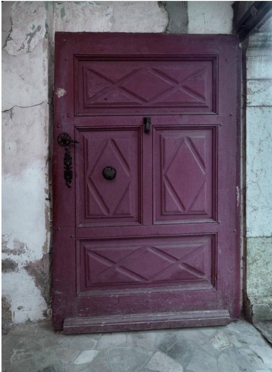
Détail : vantail de la porte d'entrée.
