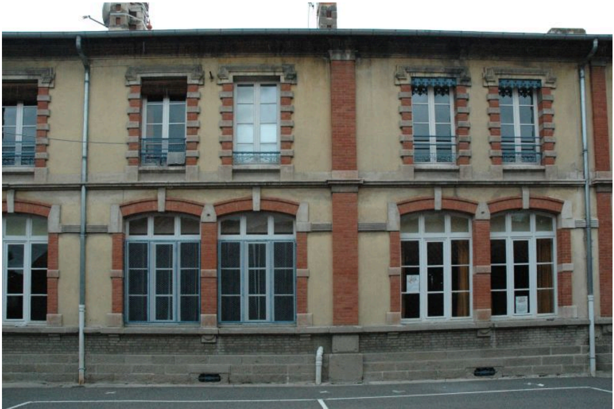
Vue partielle des travées jumelées.
