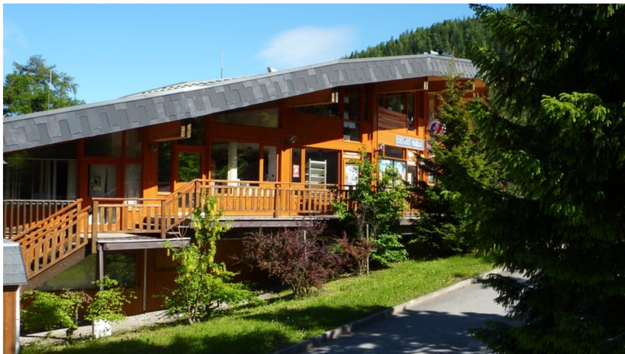
Les escaliers extérieurs
