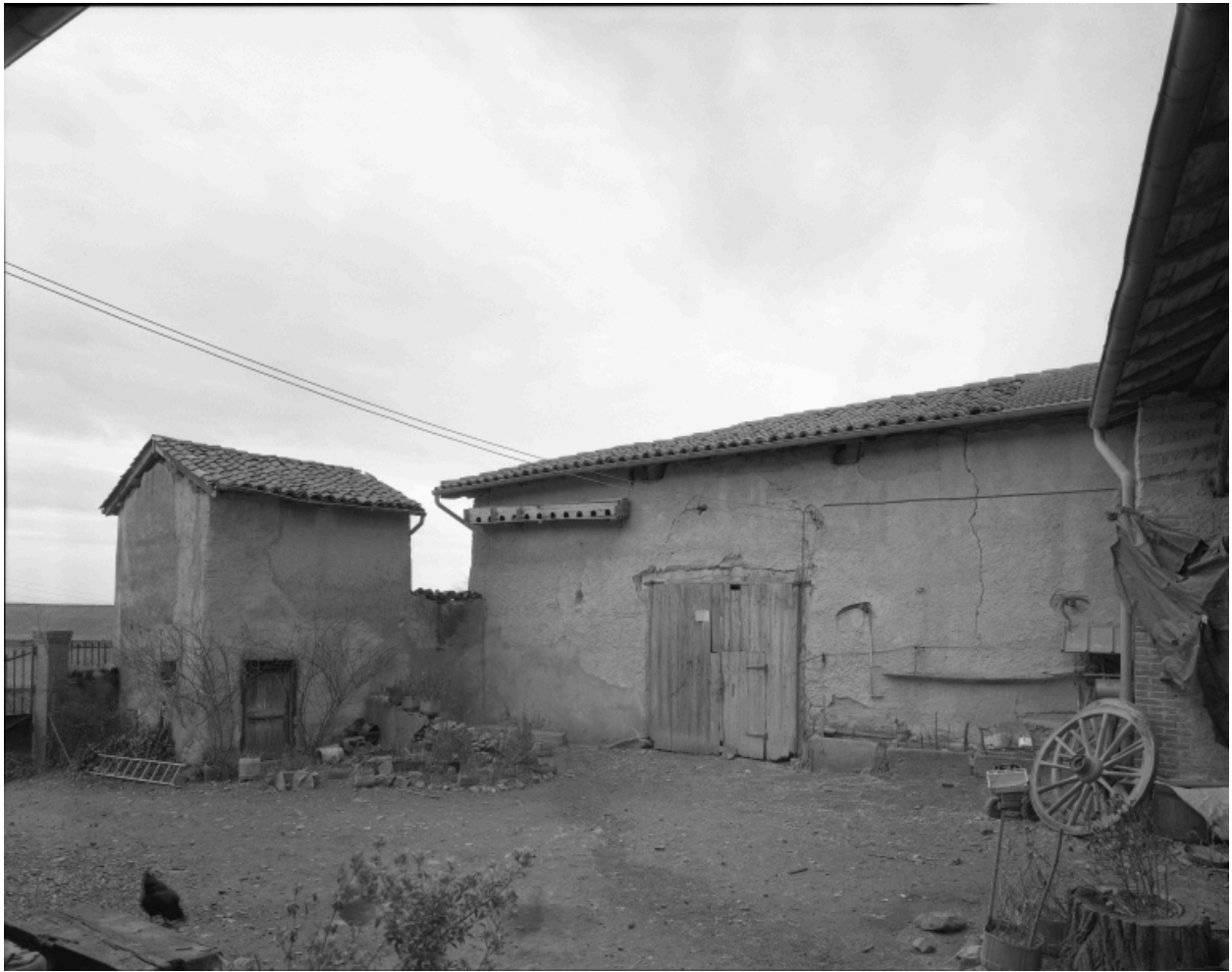
Vue d'ensemble de la grange-étable et du fournil, depuis le nord-ouest.
