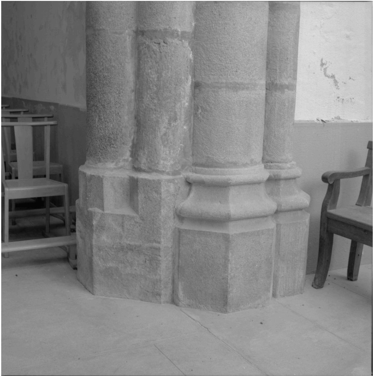
Détail de la base de la pile ouest entre collatéral et transept nord.
