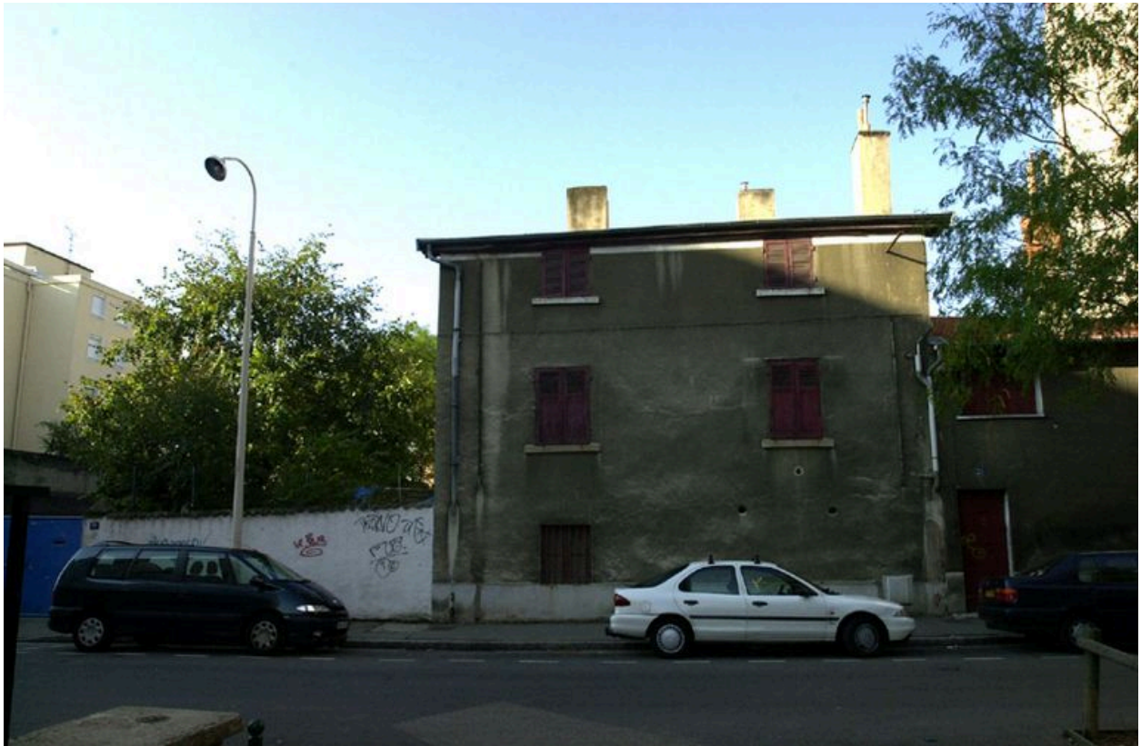
Elévation sur rue du corps de bâtiment sud
