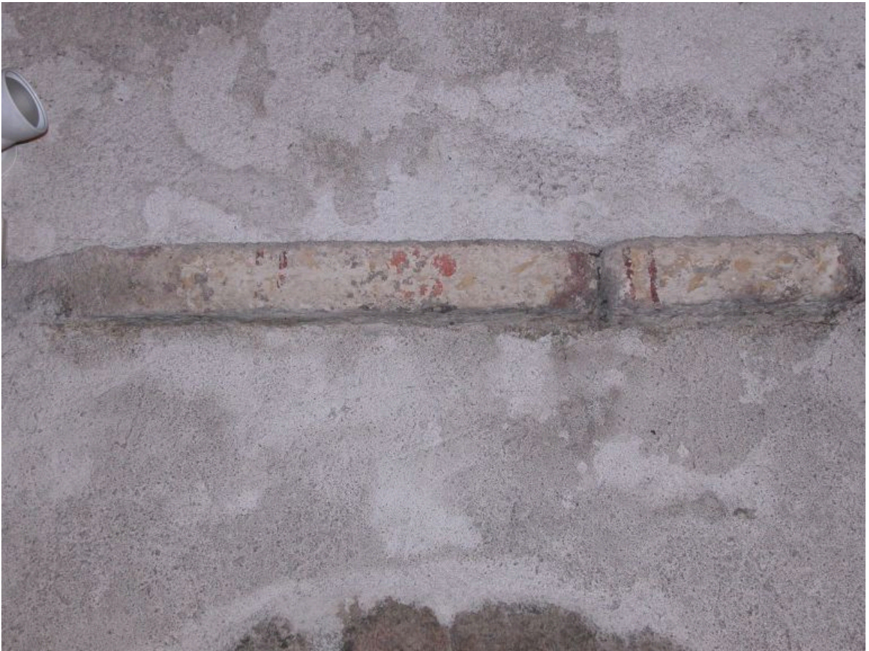
Détail du bandeau au départ de la voûte en berceau du choeur, au-dessus de l'arcade ouvrant sur la chaufferie.
