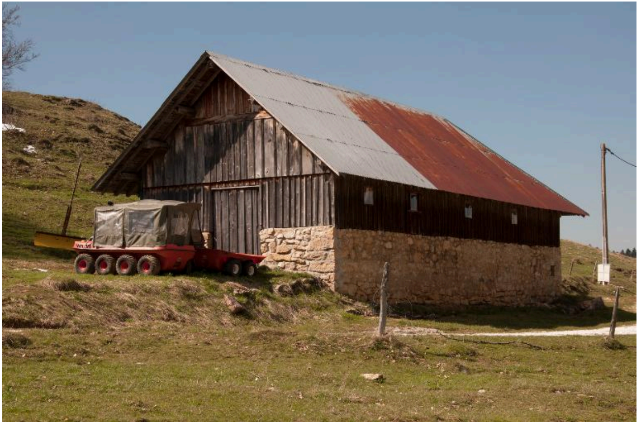
Vue de l'étable sud, depuis le sud-est.
