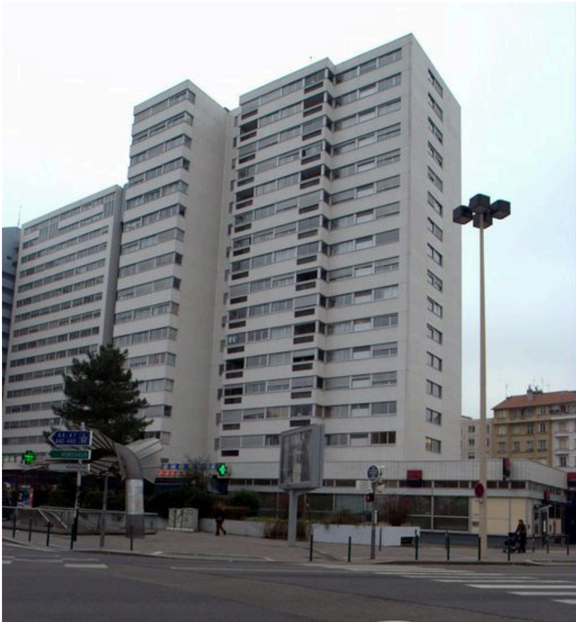
Les corps de bâtiment nord depuis l'est
