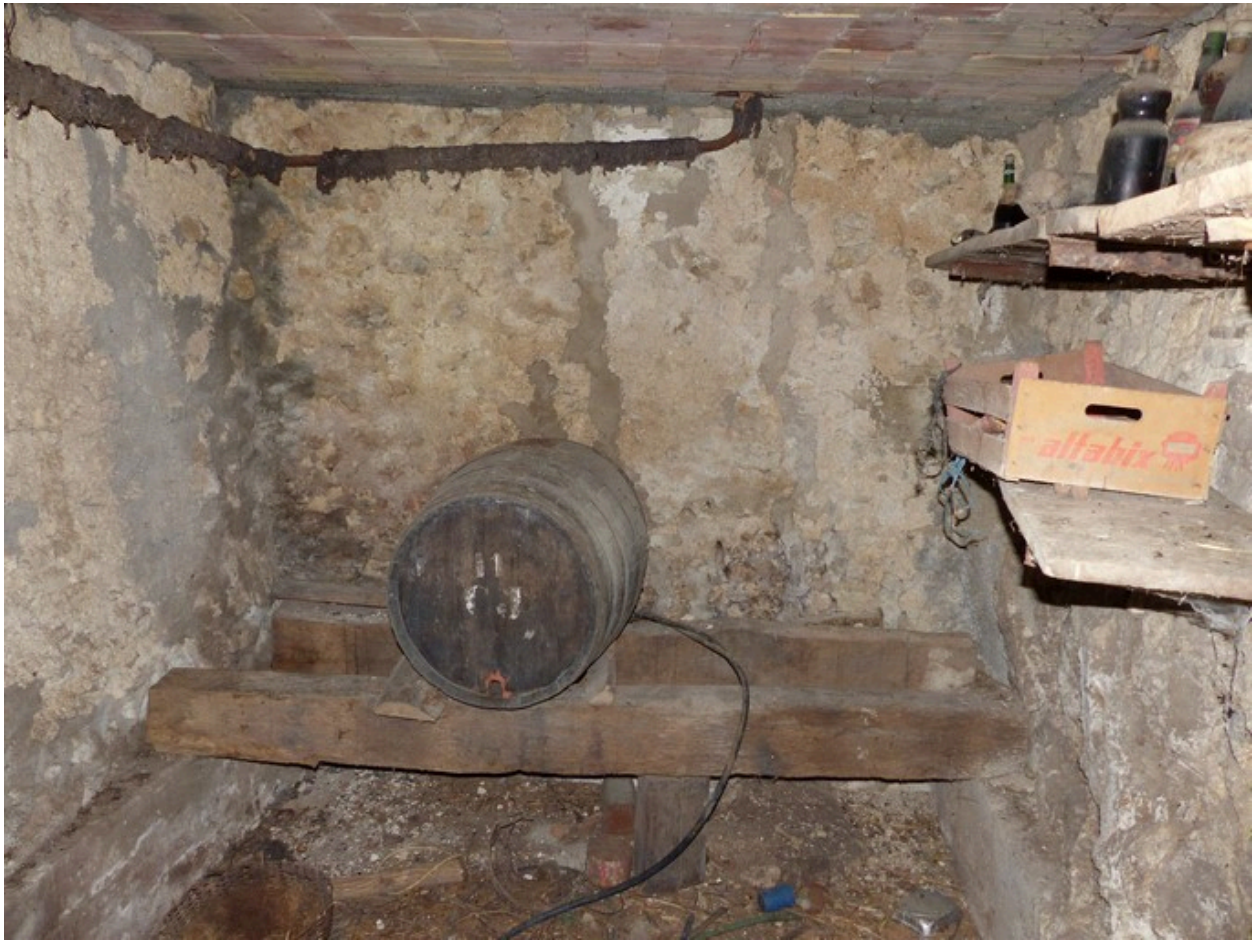
Ensemble occidental. Etage de soubassement, cellier. Vue de volume prise de l'est.
