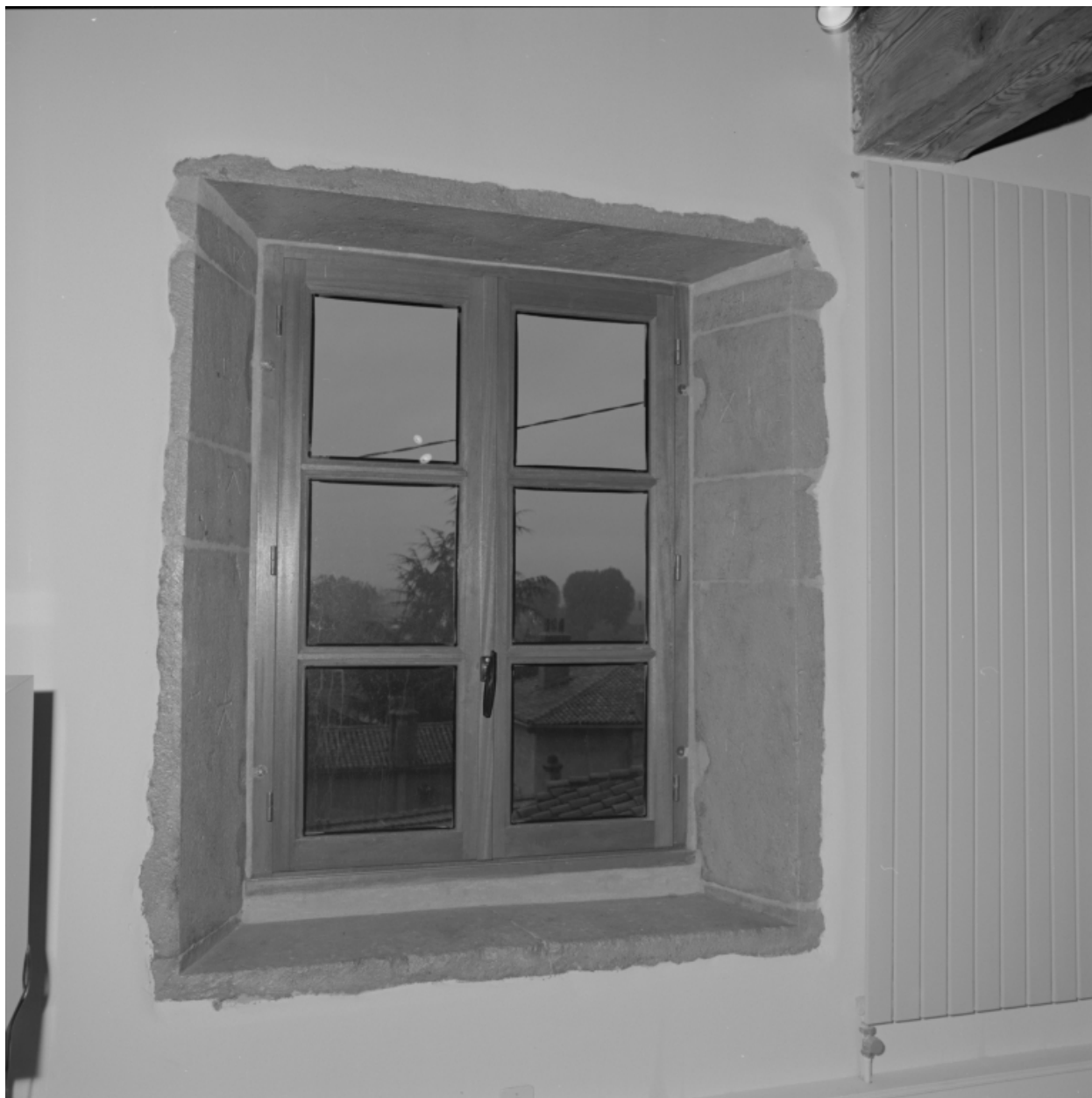
Fenêtre avec marques de tâcheron.
