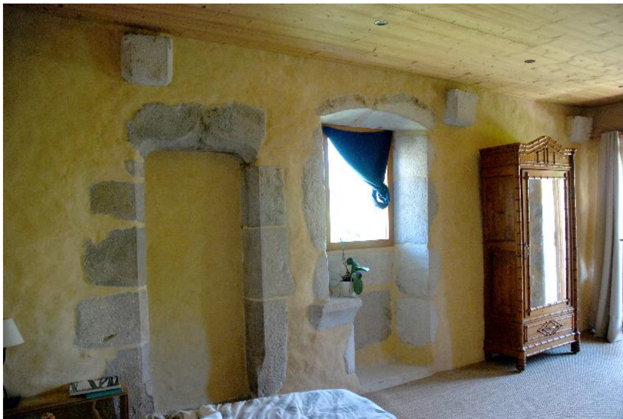
Vue intérieure du logis : porte ancienne et fenêtre à coussiège.
