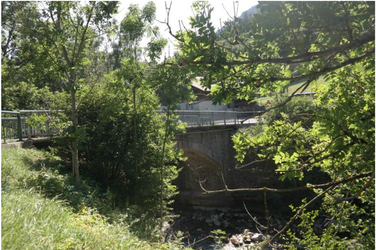
Pont de Centfontaine, vue de la face aval
