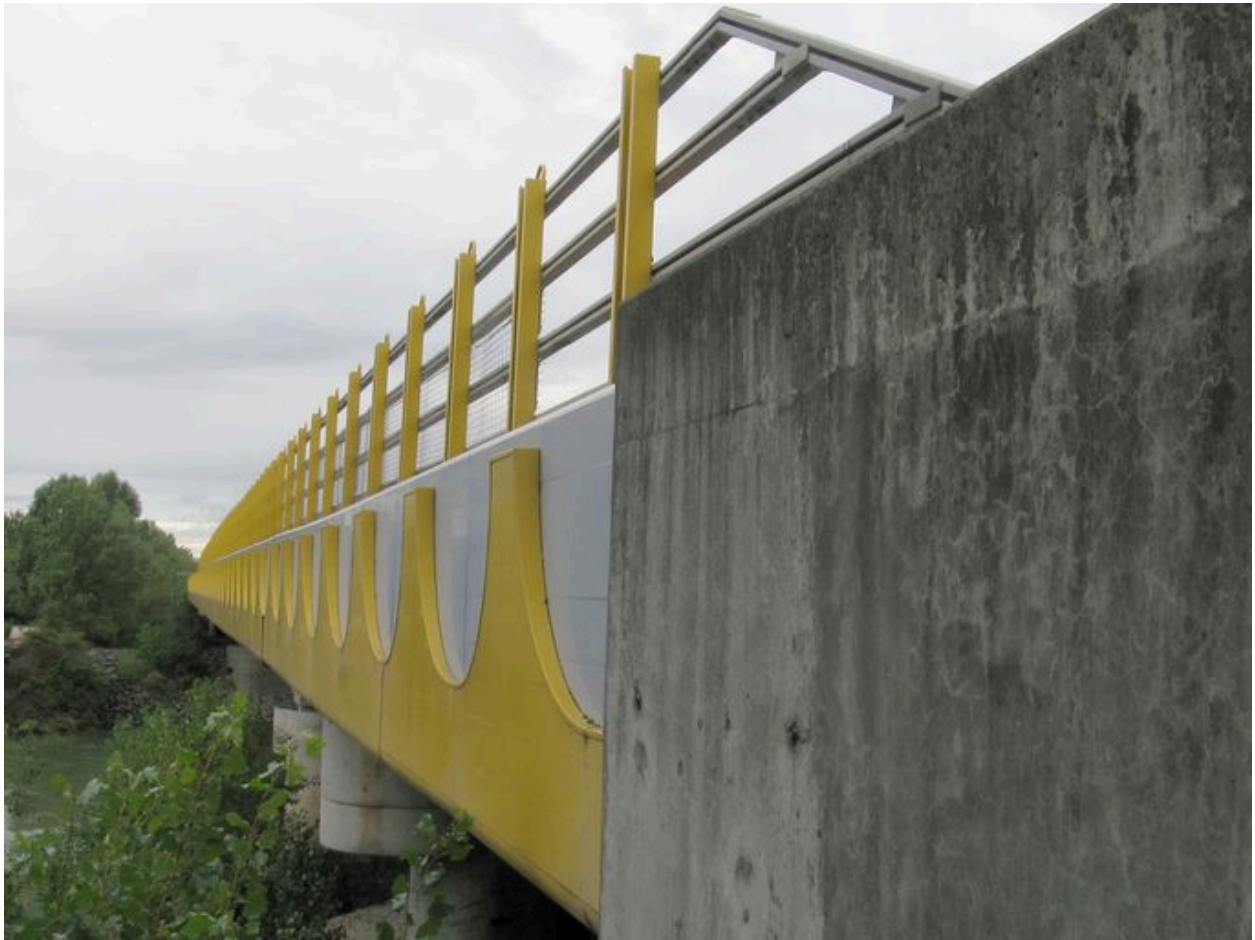
Vue partielle, de côté, tablier et parapet, face amont (depuis la rive droite)
