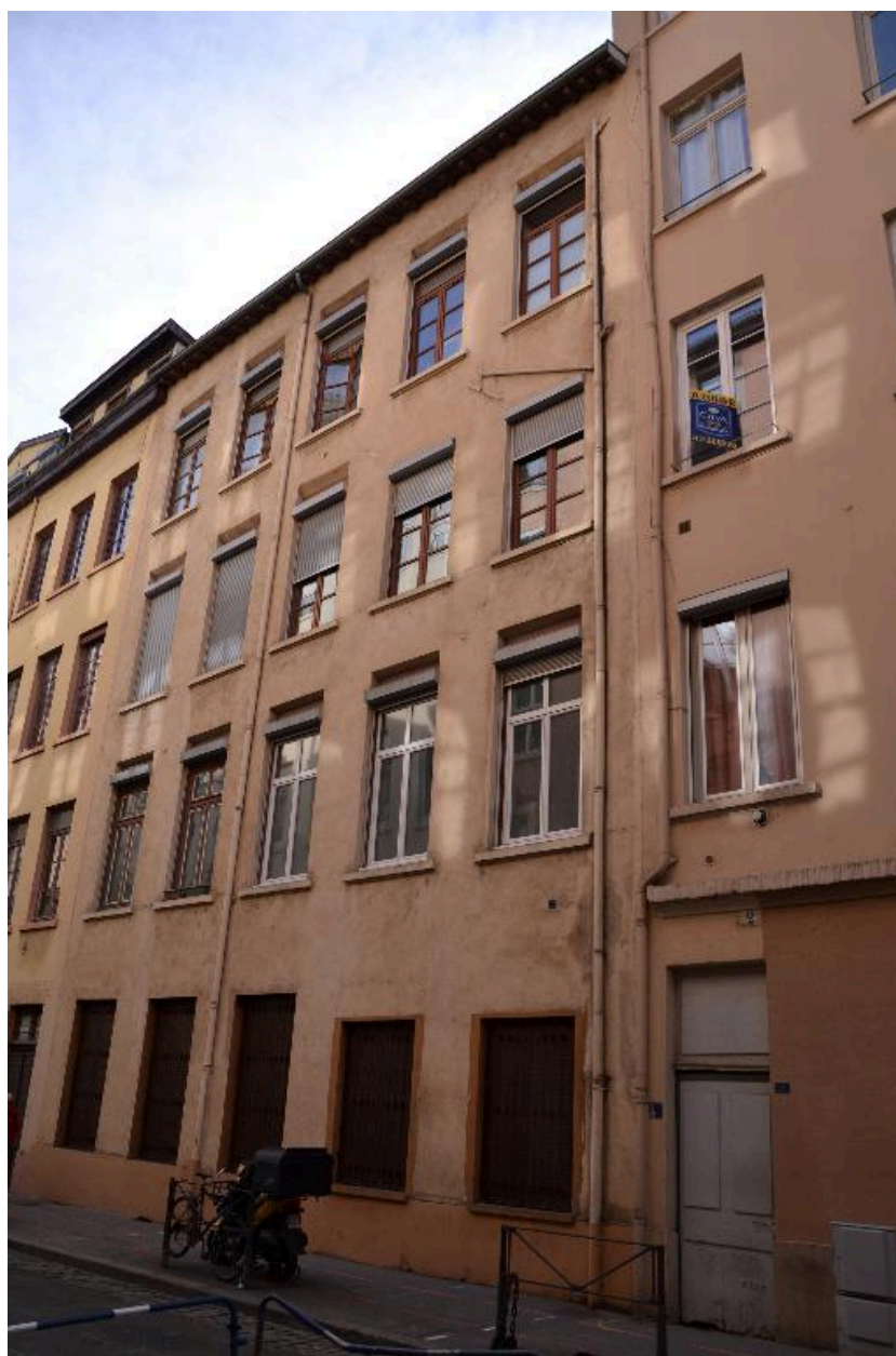
Vue d'ensemble façade nord
