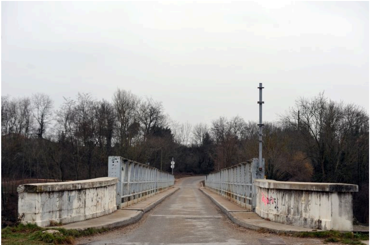
Vue générale, de dessus, chaussée (depuis la rive droite)
