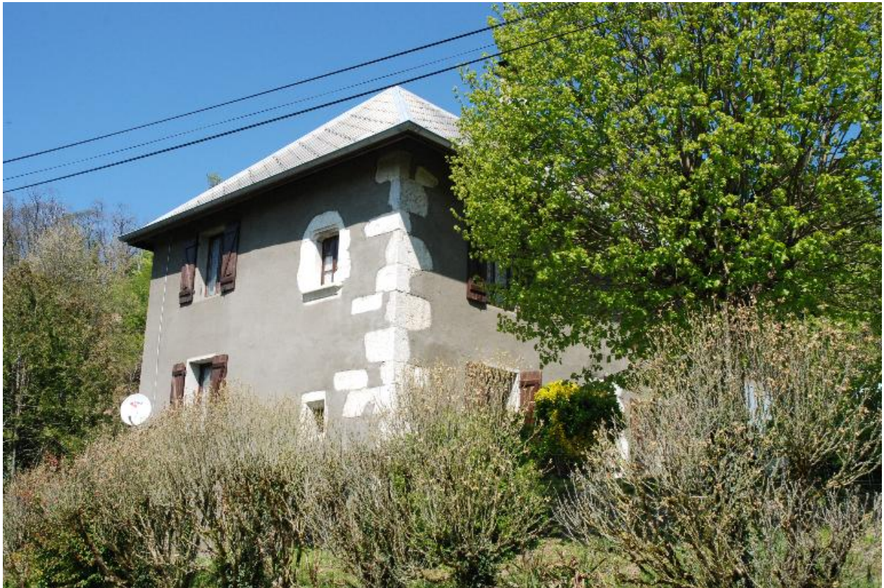
Le Crouzet, Ferme, parcelle D3 454, vue d'ensemble du mur pignon.
