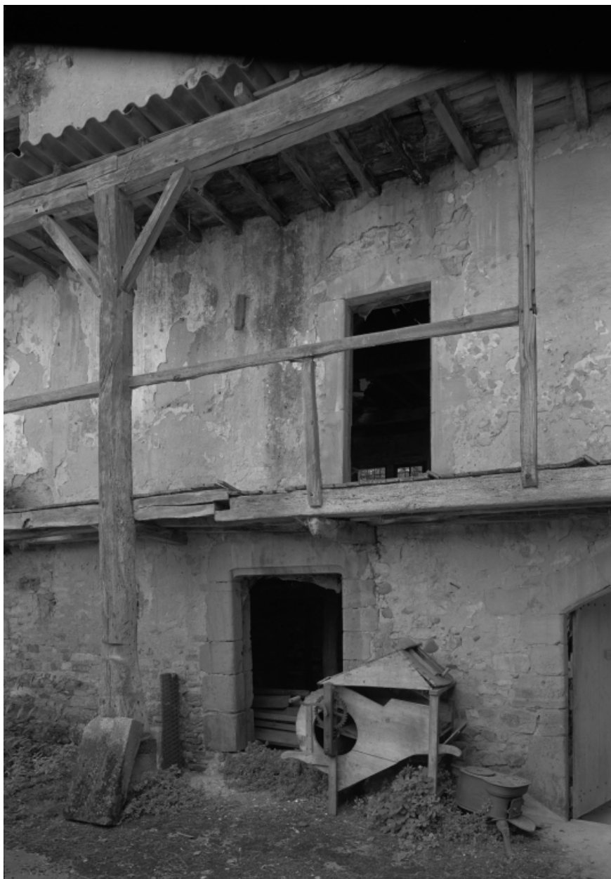
Aile gauche, élévation sur cour : 1er et 2ème niveau de la galerie sur poteaux.
